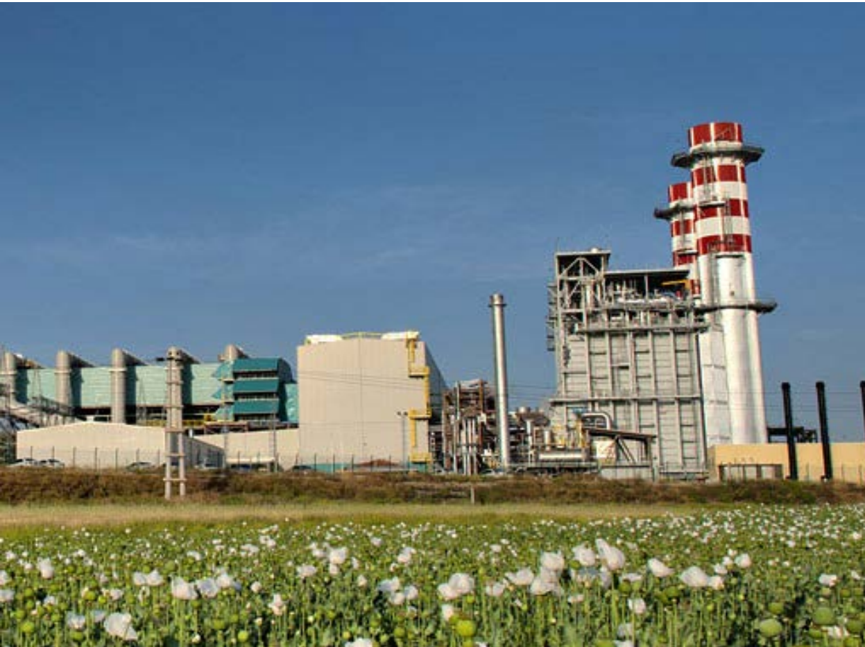
Kraftwerk Denizli, Türkei
