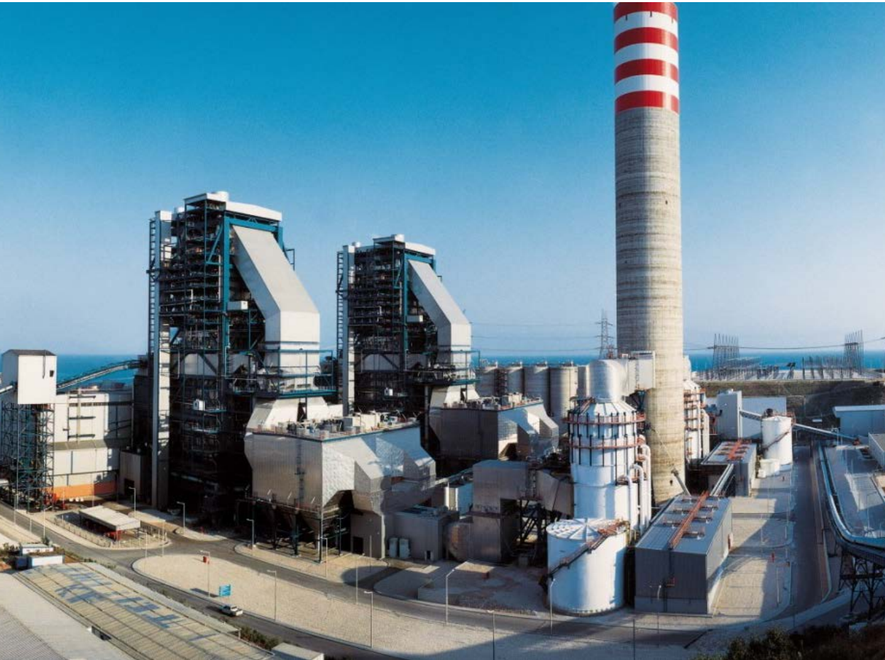
Das STEAG-Kraftwerk Iskenderun, Türkei
