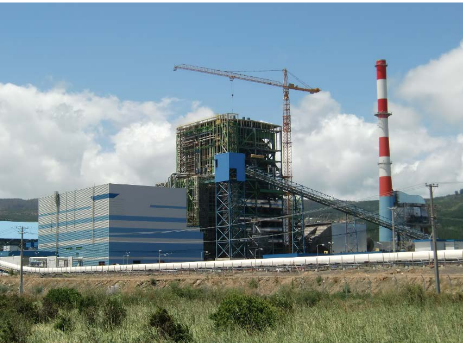
Kohlekraftwerk St. Maria I in Coronel, Chile (Bauphase)
