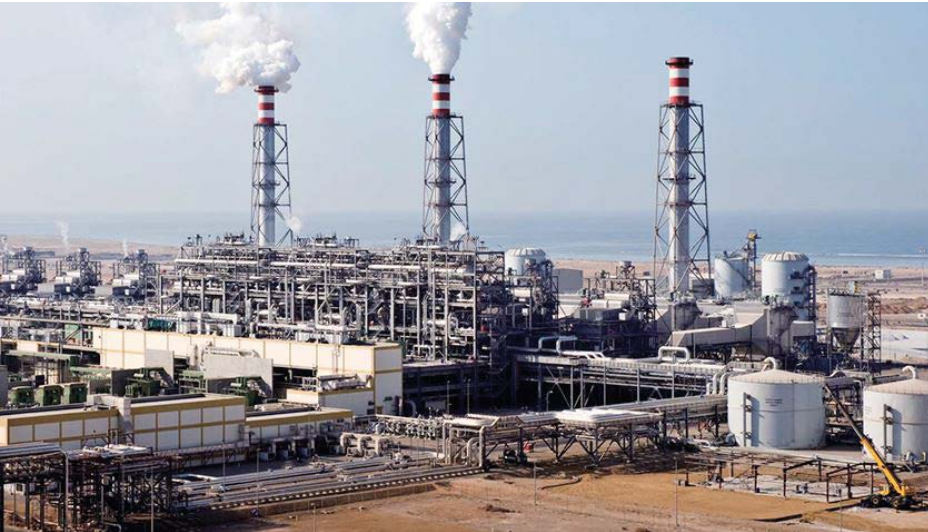
RAWEC Kraftwerk im PetroRabigh-Komplex Phase 1, Saudi-Arabien
