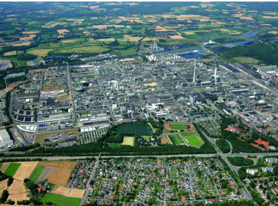
Chemiapark Marl, Deutschland
