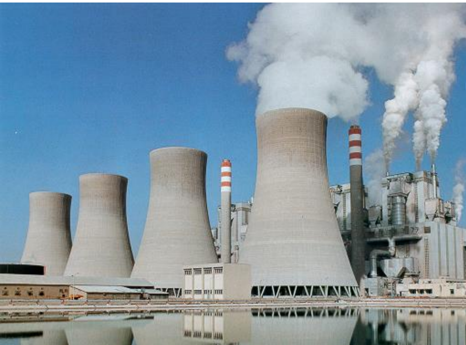
3 x 330 MW el Çerkezköy Projekt
