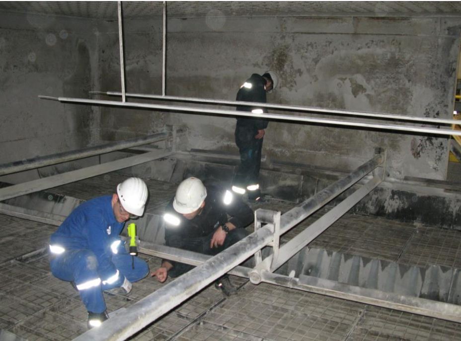
SCR DeNOx des kohlegefeuerten Kessels in der Anlage Yalova von AKSA Akrik
