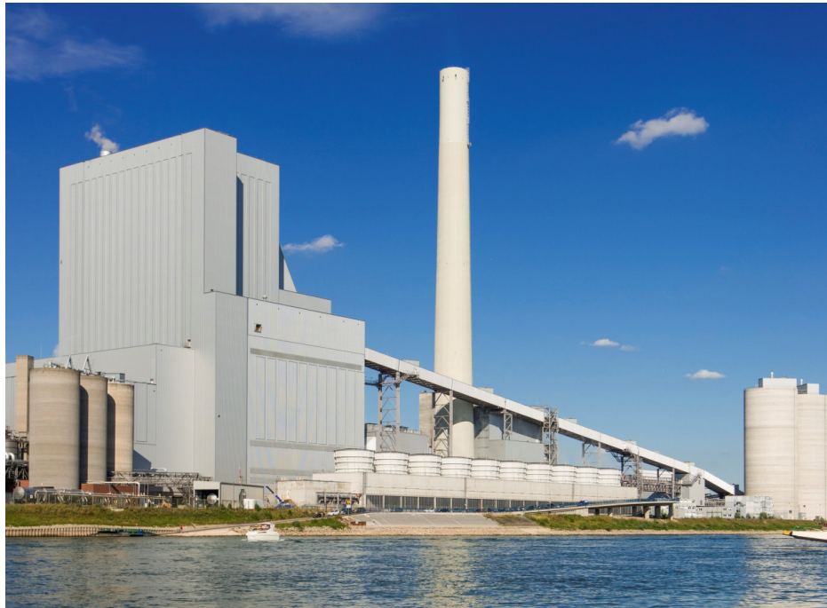
Block 9 Grosskraftwerk Mannheim
