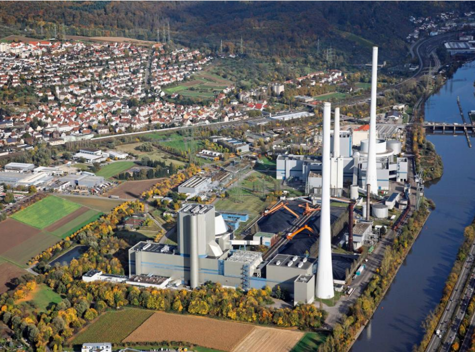
EnBW Heizkraftwerk Altbach
