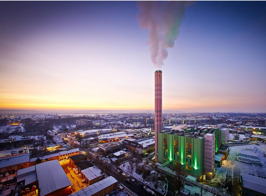
MVA der Stadtwerke Bonn
