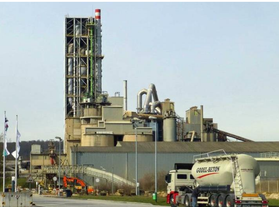
Zementwerk der Firma OPTERRA in Walzbach-Wössingen
