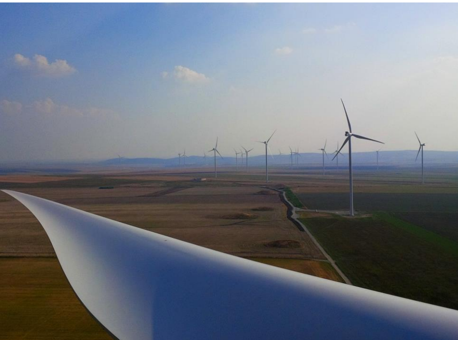
Der Windpark „Crucea Nord“ verfügt über 36 Anlagen mit je 3 MW Leistung
