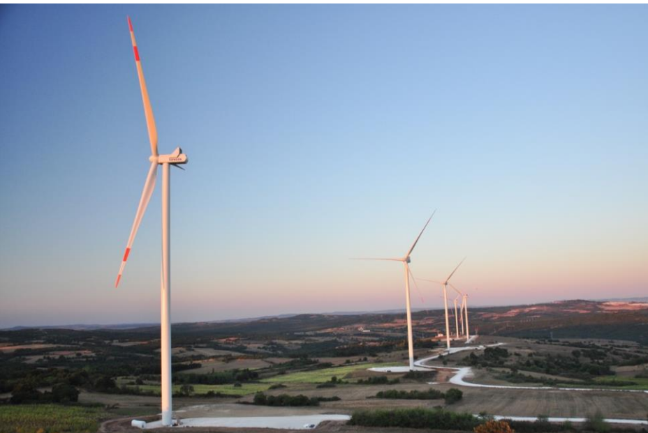
Der Windpark „Süloglu“ im Nordwesten der Türkei hat eine Gesamtleistung von 66 MW
