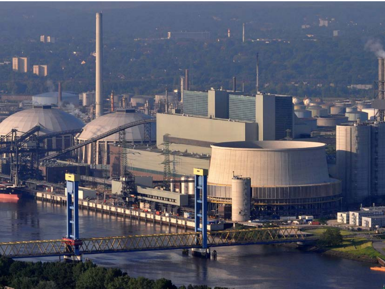
Block A und B, Kraftwerk Maasvlakte
