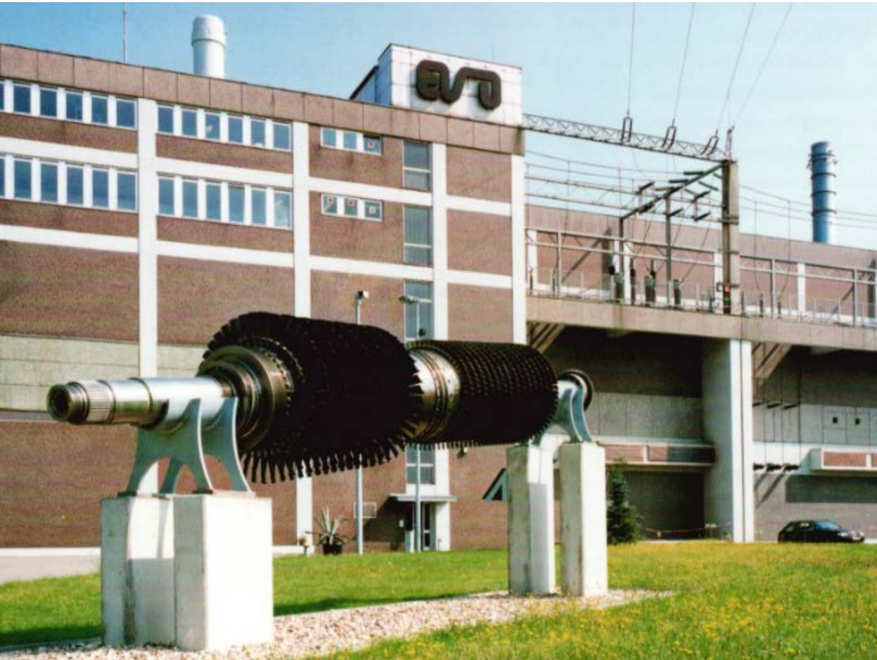
Heizkraftwerk Oberhausen Sterkrade
