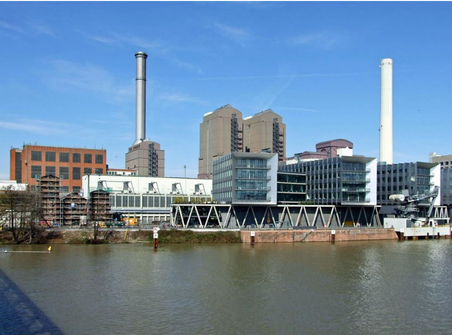
Kraftwerk HKW West
