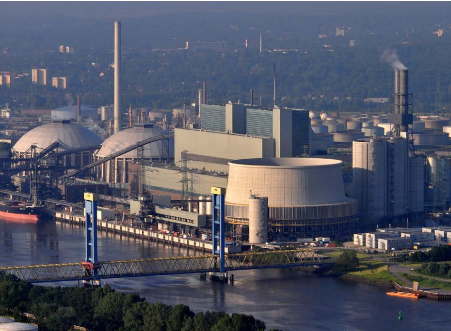
Block A und B Kraftwerk Moorburg, Hamburg
