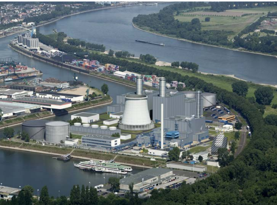
GuD-Heizkraftwerk Niehl 3, Köln/Deutschland
