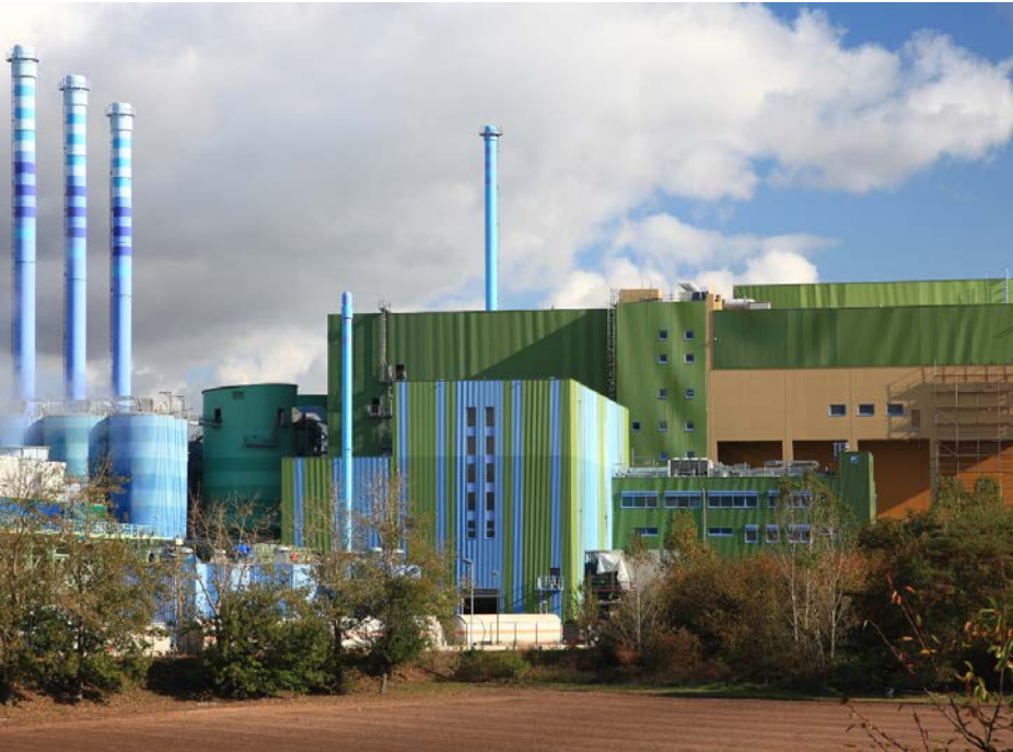
Ersatzbrennstoff-Verbrennungsanlage, Infraserv Höchst, Frankfurt
