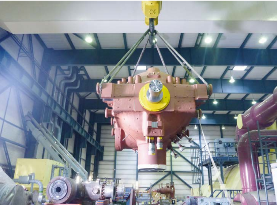
Transport des Hochdruck-Moduls am Standort Herne
