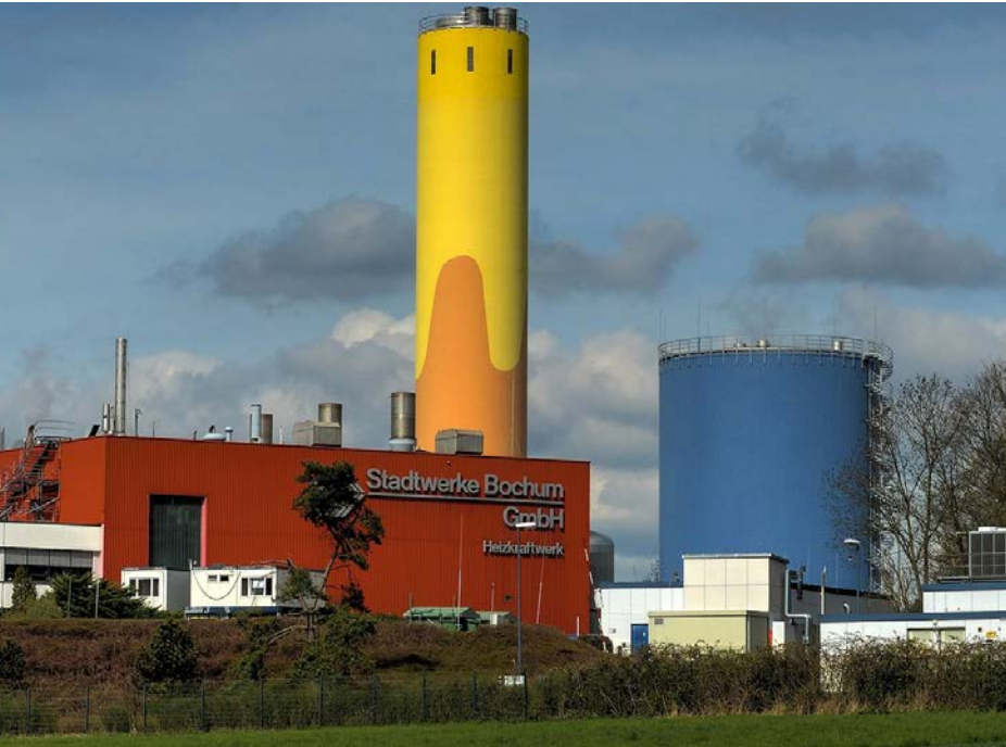
HKW Hiltrop mit Wärmespeicher
