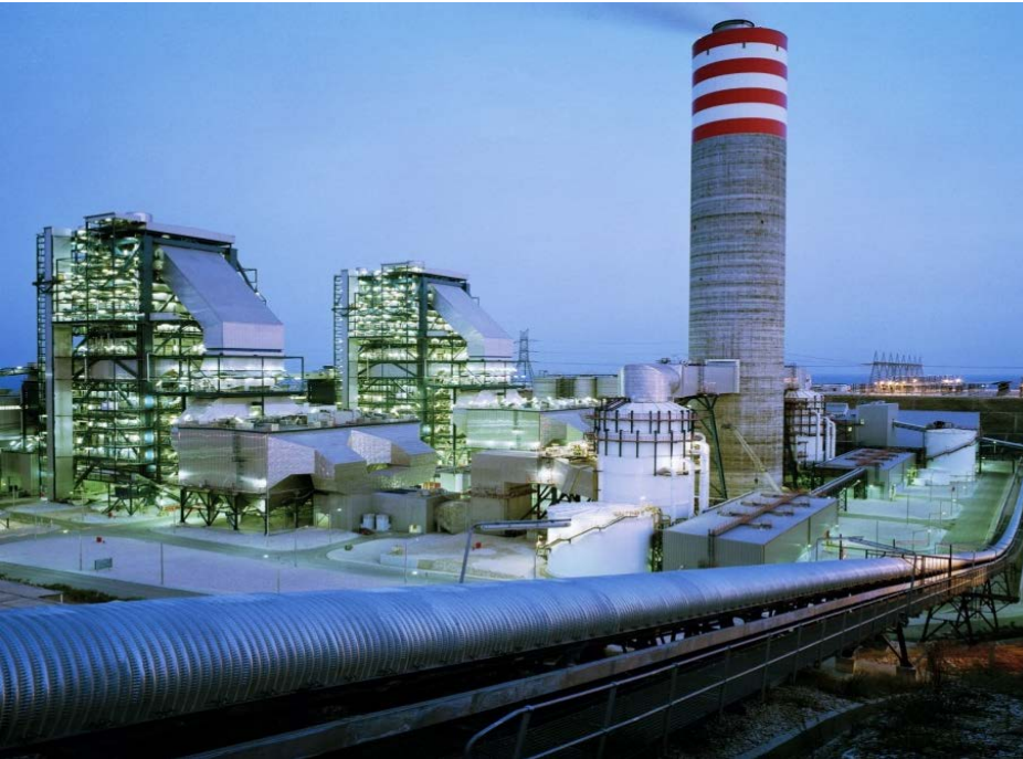
Kraftwerk Sugözü (Iskenderun, Türkei)
