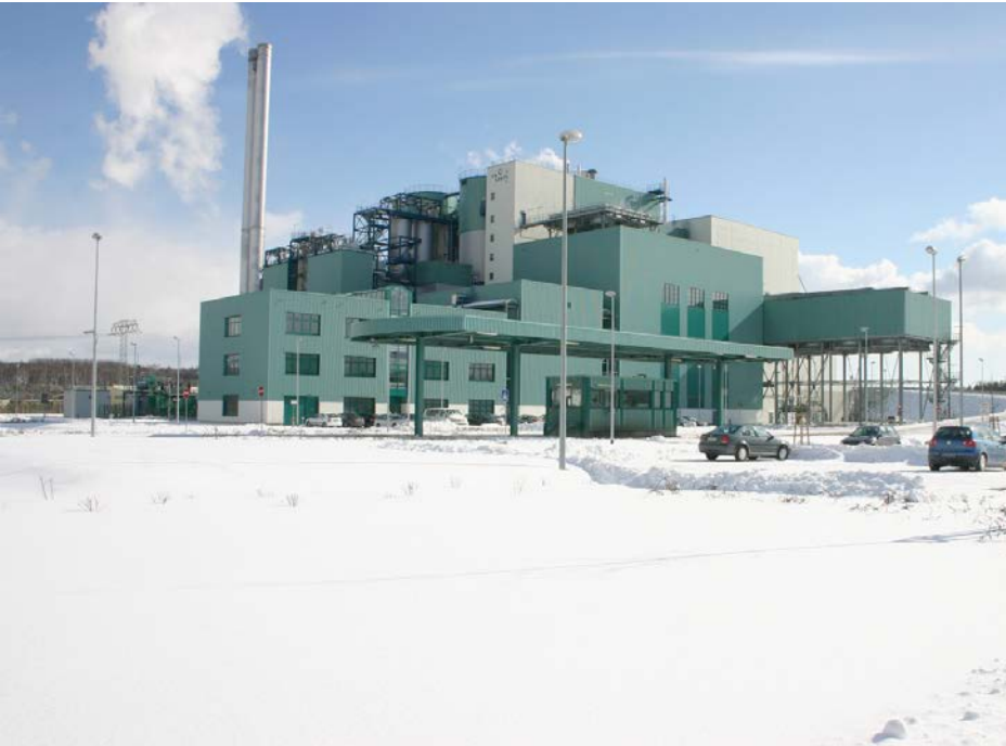
Müllverbrennungsanlage T.A. Lauta, Lauta
