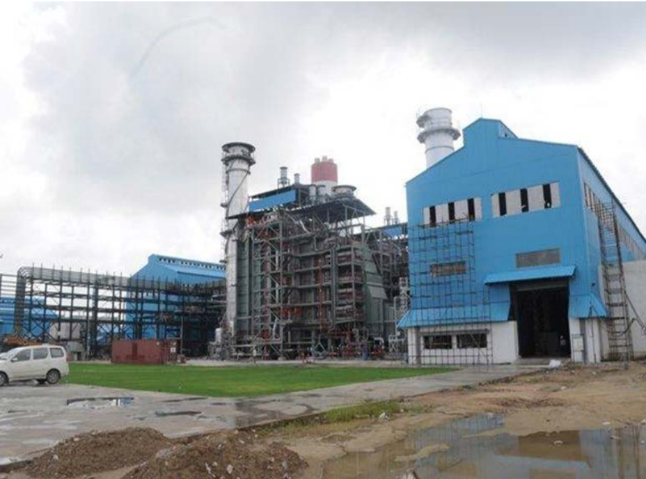
GuD-Raffinerie-Kraftwerk Bathinda, Punjab, Indien
