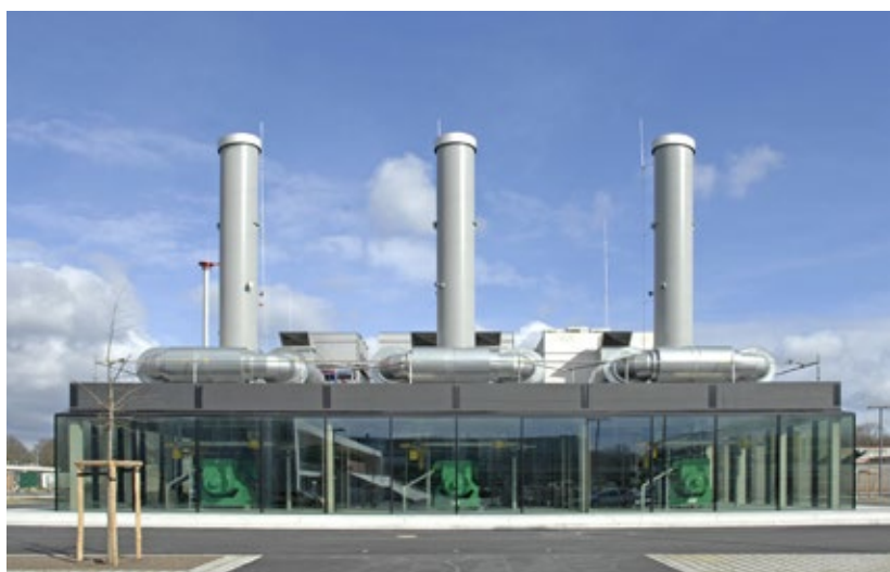
Gasbetriebenes Blockheizkraftwerk
