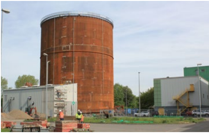
Fernwärmespeicher (Bauphase) zur Erhöhung des KWK-Anteils
