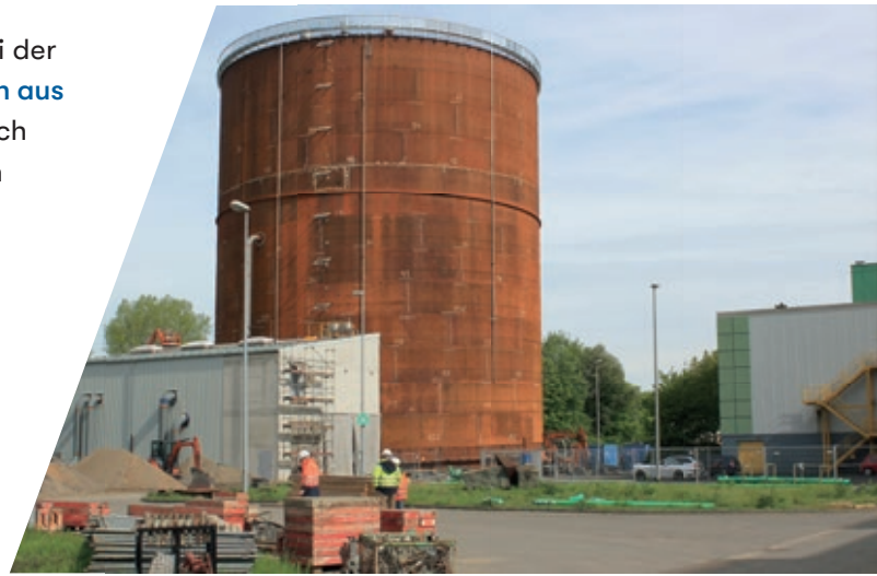
Fernwärmespeicher (Bauphase) zur Erhöhung des KWK-Anteils
